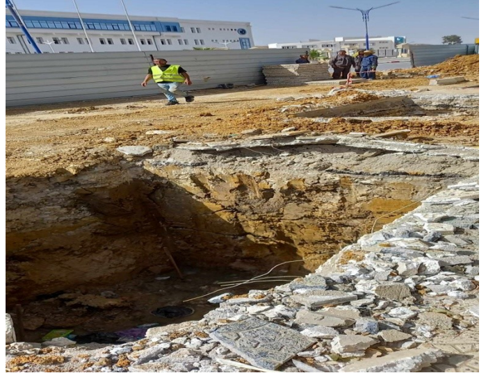
أشغال حفر الأساسات
