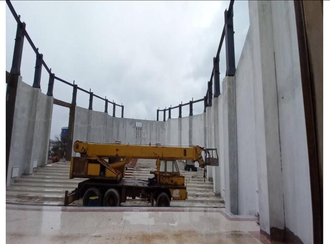
أشغال أعمدة وروافد الرابطة لهيكل السقف الحديدي للمسمع
